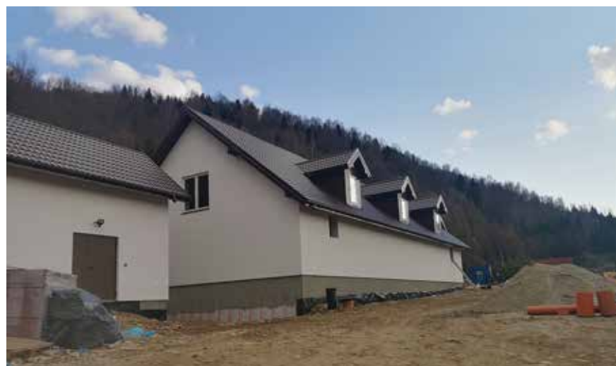
Modernizacja i rozbudowa oczyszczalni ścieków w Tylmanowej
