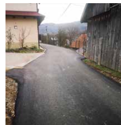
Nowy asfalt w os. Wybrańce w Tylmanowej
