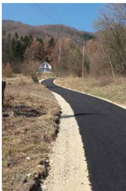
Nowy asfalt w os. Obłaz - Makowica w Tylmanowej
