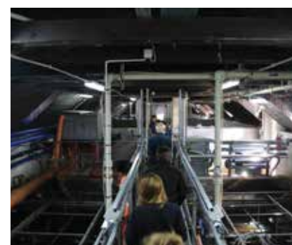
Modernizacja i rozbudowa oczyszczalni ścieków w Tylmanowej
