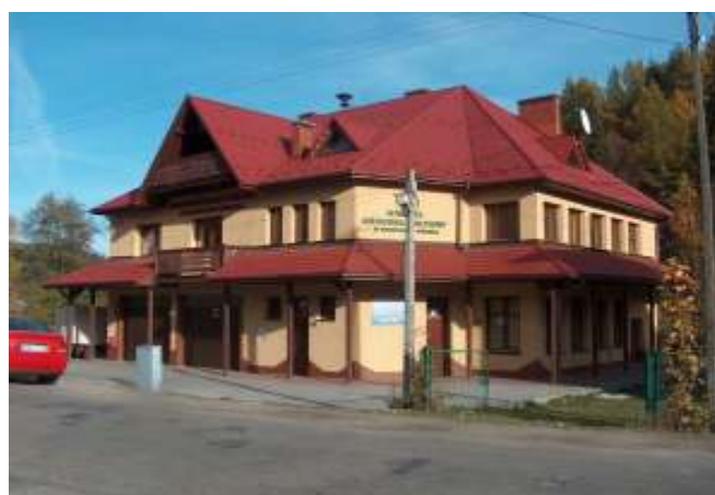
Budynek Wiejskiego Ośrodka Kultury i OSP w Ochotnicy Górnej po przebudowie
