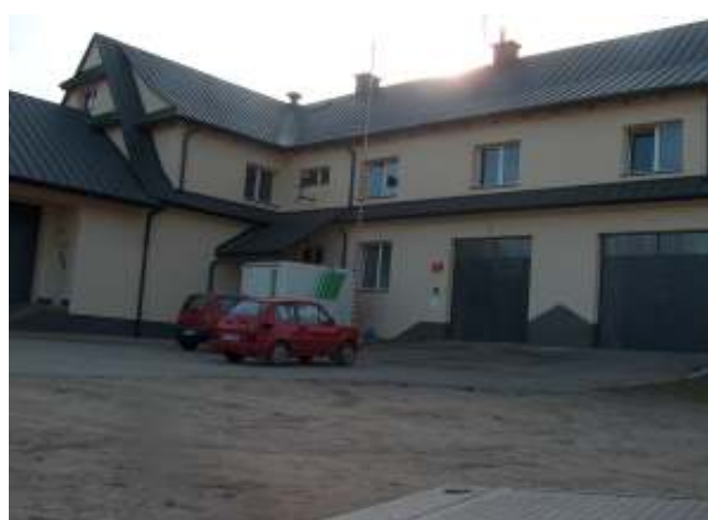
Budynek Wiejskiego Ośrodka Kultury w Ochothnicy Dolnej po remoncie
